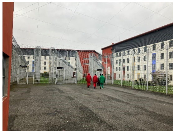
Place panoptique donnant vue sur les bâtiments B et C
