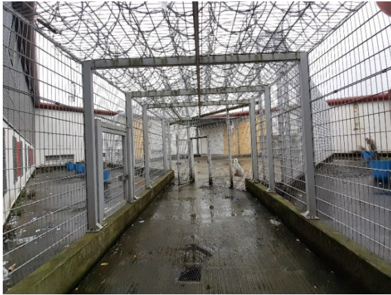
Accès à la cour de promenade du QA
